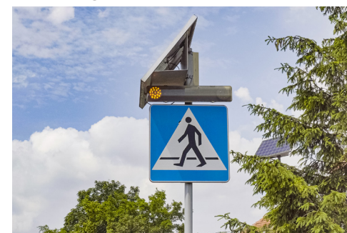
Na remontowanych trasach drogowcy instalują bariery energochłonne, balustrady, aktywne przejścia z sygnalizacją oraz wymieniają oznakowanie pionowe i niosą poziome.
