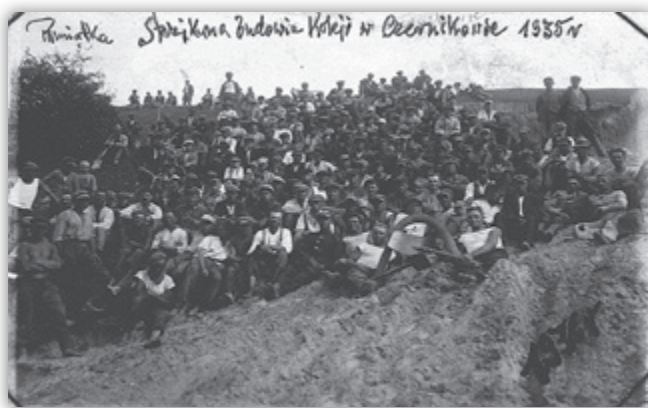
Strajk na kolei w Czernikowie (Wygodzie) w 1935 r. podczas budowy mostu kolejowego
