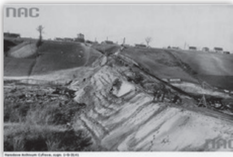
Widok nasypu w Witowie. NAC
